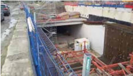
In 23 Bauabschnitten wurden dann die Tunnelsohle, die Seitenwände und die Tunneldecke hergestellt. Die Gesamtmenge des benötigten Transportbetons beläuft sich auf 200.000 m<sup>3</sup> (zur Verdeutlichung: 25.000 Transportbetonmischfahrzeuge!). Die benötigte Menge an Stahl beträgt 24.000 t, was der
